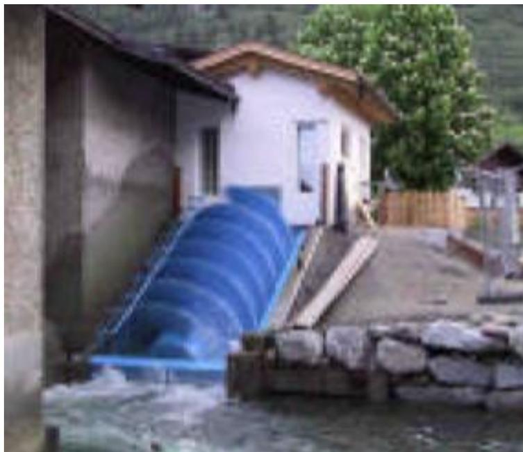
**Figura 8** – Esempio di applicazione della vite perpetua
