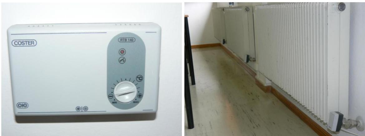
**Figura 37** – Regolatore di temperatura sulle pareti delle aule (foto a sinistra) e servomotori sui radiatori (foto a destra)
