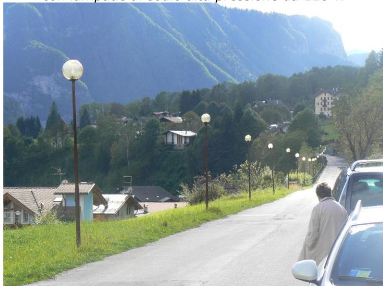
**Figura 45** – Globi trasparenti equipaggiati con lampade ai vapori di mercurio da 125 W
