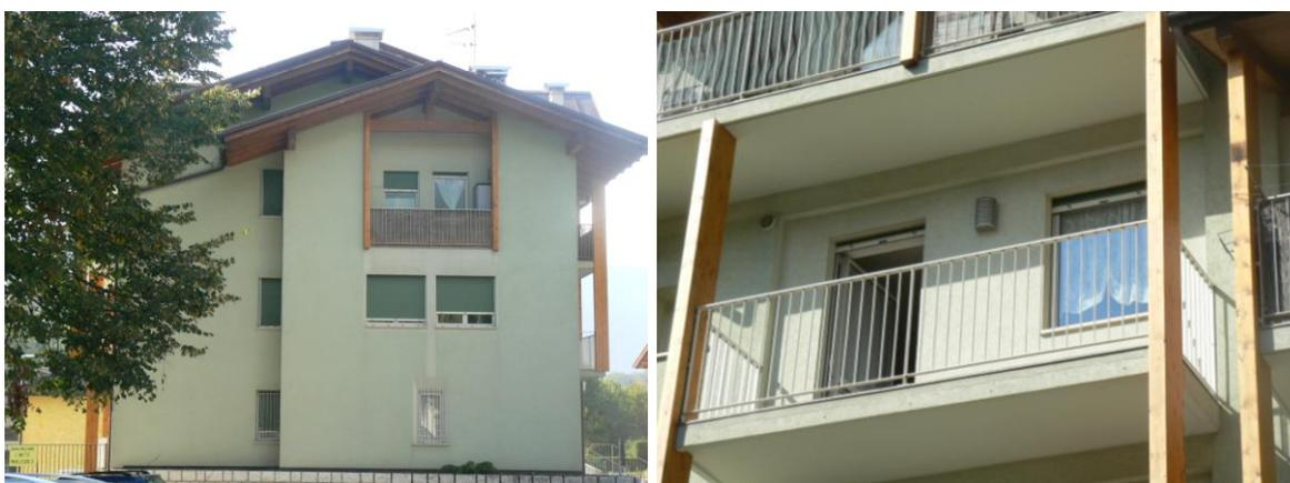
**Figura 34** – Facciata a nord priva del cappotto (foto a sinistra) e particolare di una porzione di parete non coibentata in corrispondenza di un poggiolo (foto a destra)
