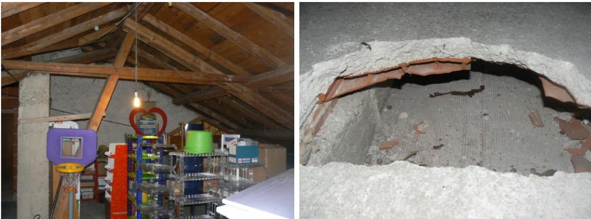
**Figura 30** – Sottotetto non riscaldato (a sinistra) e foro nel solaio esistente che ha consentito di verificarne l'esatta composizione attuale (a destra)
