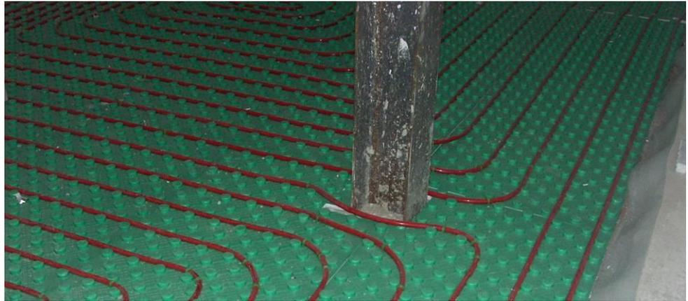
**Figura 4** - Sistema di riscaldamento a bassa temperatura
